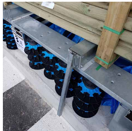
Butée de Sécurité sur Oméga incliné
